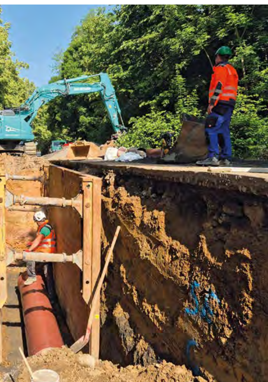
Die Kanalrohre werden in einem gemischtkörnigen Fels-Lehm-Gemisch der Bodenklasse 6 und in Tiefen zwischen 2,00 und 2,50 m verlegt
