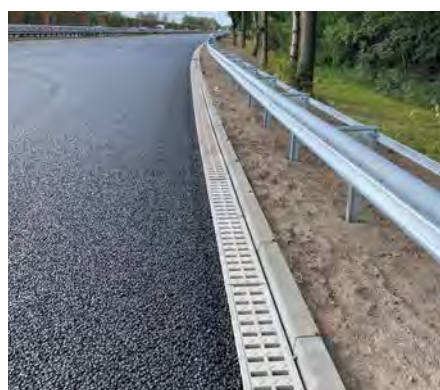
Dank ihrer Länge von nur einem Meter lassen sich die Einzelelemente flexibel auch in radialen Bereichen integrieren
