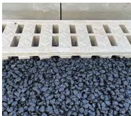
Im Einbau deutlich erkennbar die seitlichen Öffnungen zur seitlichen Entwässerung bei offenporigem Drainspalt
