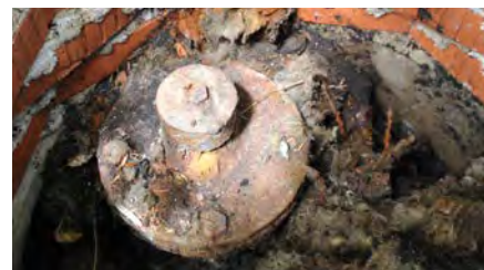
Korrodierte Armaturen aufgrund undichter Schächte
