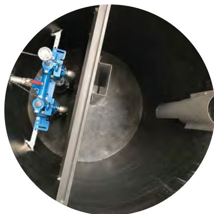
Die PE-Auskleidung erhöht die Beständigkeit gegenüber Abwasser mit schwankenden Temperaturen
