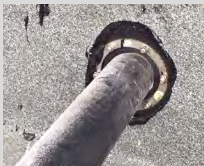
Einbindung der Medienleitung in die Abdichtungsbahnen
