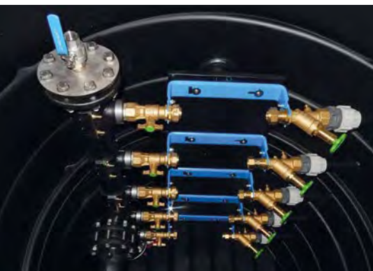
Wasserzählerschacht mit mehreren Anschlüssen
