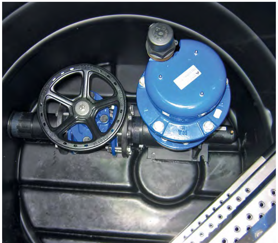
Exzentrischer Einbau bringt mehr Platz
