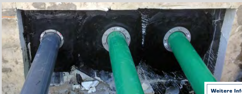
Der FKF zur Sanierung eines Kellers mit schwarzer Wanne
