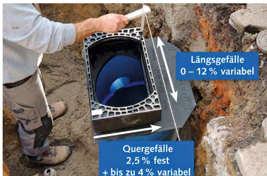
Ein Quantensprung in der Straßenentwässerung: Der Aufsatz des neuen Funke Straßenablaufs ist in Längs- und Querrichtung verstellbar
