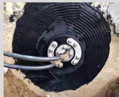
Der FKF als geteilte Ausführung für bereits verlegte Kabel
