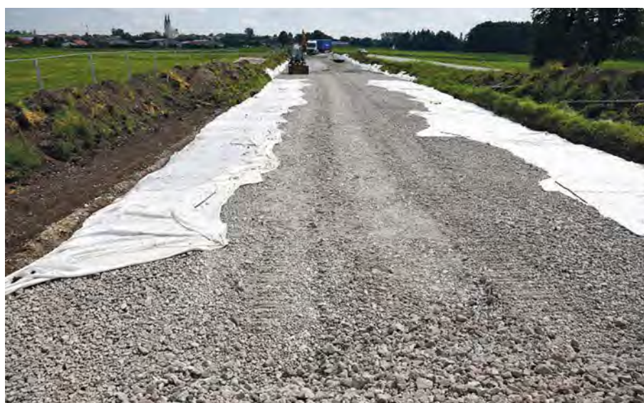
Baustellenansicht: FRANK FHG wird zweilagig eingeschlagen eingebaut und verbleibt nach Rückbau der Ballastierung als Gründungspolster
