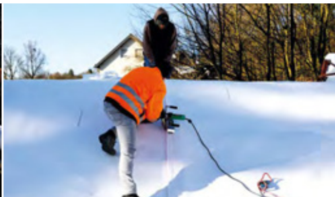
Verschweißen der TPD-Bahnen
