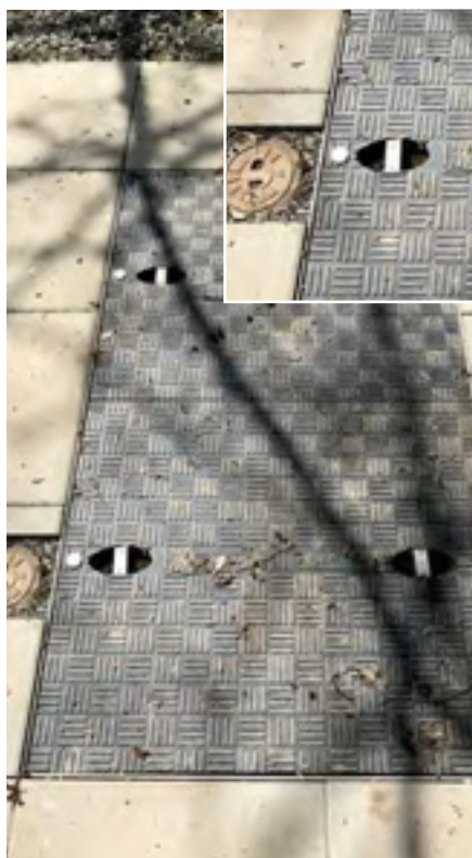
Die Sonderabdeckung von KHK ist durch Glasfaserverbund als Material für eine dauerhafte Nutzung ausgelegt und berücksichtigt zudem Telehydrant-Ausheber (Foto: KHK, Karlsruhe)
