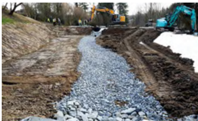
Fertig neu gestaltetes RBB mit offenem Gerinne
