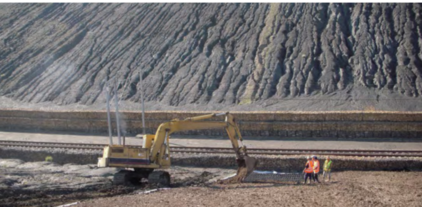
Rillenerosion über meterlange Böschung
