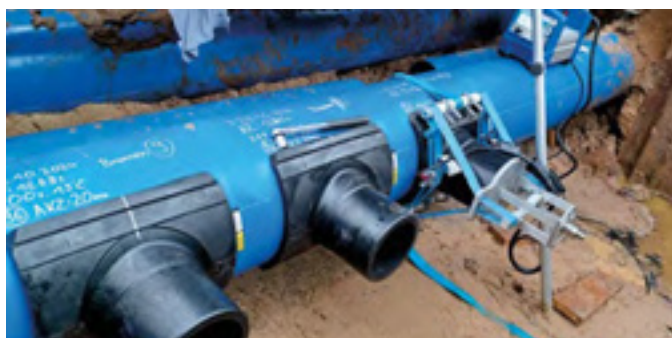
Sattel mit Spitzende Universal wird mit Aufspanngerät UNITOP 250 und FRIAMAT 7 auf eine Trinkwasserleitung d 450 geschweißt
