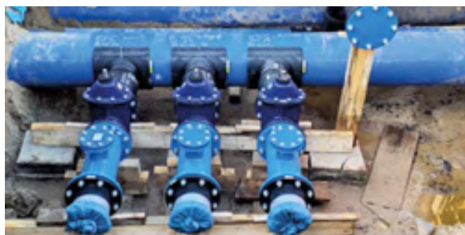
In Emmerich wurden drei neue Brunnen zur Trinkwassergewinnung mit SA UNI ans bestehende Rohrleitungsnetz angebunden
