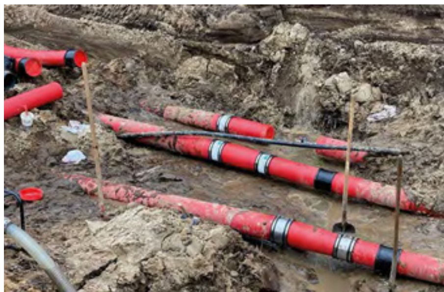
Einsatz beim Rohrübergang
