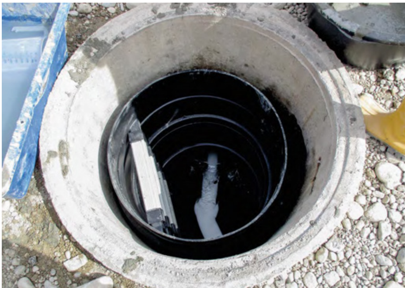
Schacht-in-Schacht-Sanierung von ROMOLD – die perfekte Alternative zum Austausch
