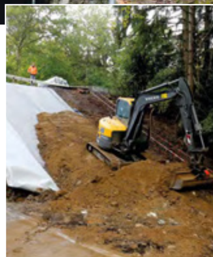
Aufbringen des Rohbodens auf dem mehrlagigen Sicherungs-, Drainage- und Abdichtungssystem
