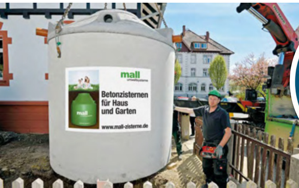
Ein Regenspeicher aus Beton wird direkt vom Lieferfahrzeug in die Baugrube gehoben (Mall GmbH)
