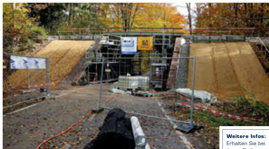
Oberflächenerosionsschutz nach Fertigstellung (unbegrünt)
