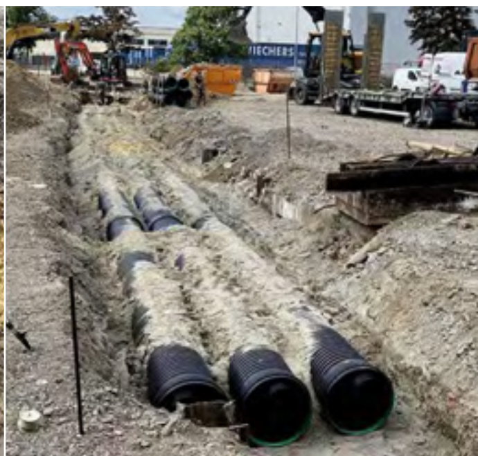
Baumaßnahme mit dem Stauraumkanal 3x AQUATUB-Rw DN 800
