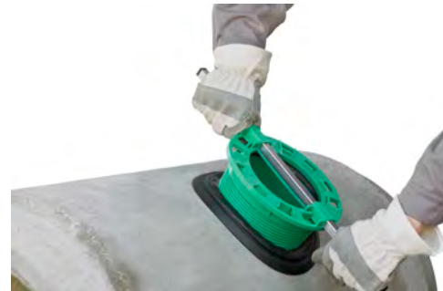
AWADOCK®-Einschraubkrone in die Anschlussdichtung einschrauben
