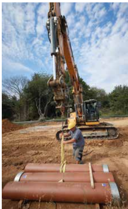
KERA.iXP-Rohr mit werkseitig aufgezogener iX.LINK-Verbindung (Foto: Steinzeug-Keramo)
