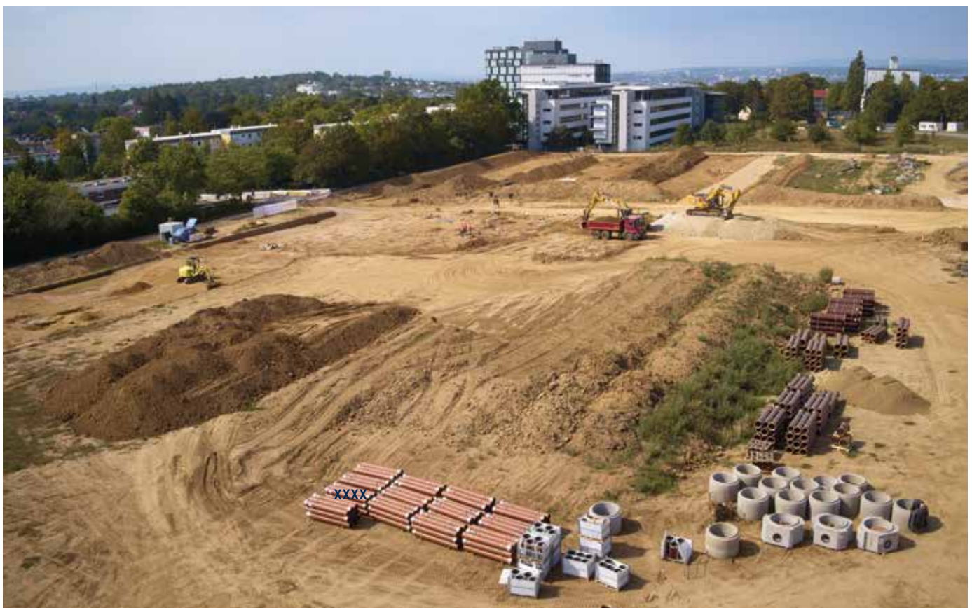
Steinzeug-Produkte von Hausanschlussleitungen ND 150 bis größere Sammelleitungen DN 400 (Foto: Steinzeug-Keramo)
