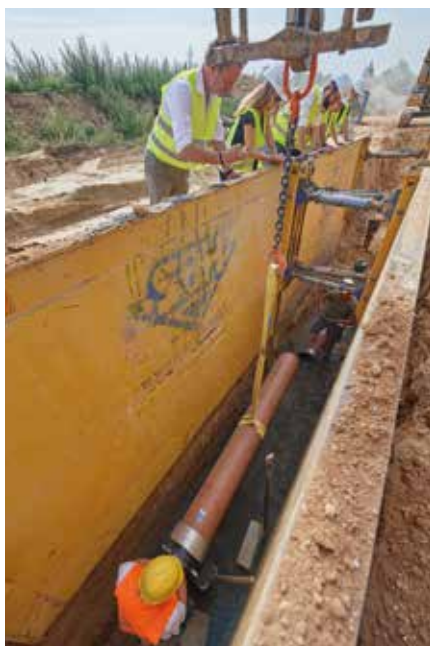
Einfache Handhabung und Verlegung mit dem iX.FIX-Installationstool (Foto: Steinzeug-Keramo)
