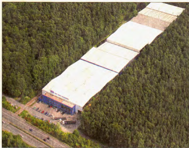
Die Luftaufnahme zeigt die weißen Hallendächer der Bieber + Marburg GmbH am Gießener Ring. Rechts daneben sollen auf 25 000 Quadratmetern weitere Lagerhallen gebaut werden. (Foto: pv)
