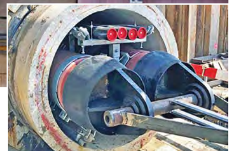
Ankunft des Doppelrohrstanges DN 600 im Zielschacht Alpenquai (Foto: TMH Hagenbucher AG, CH-8050 Zürich)
