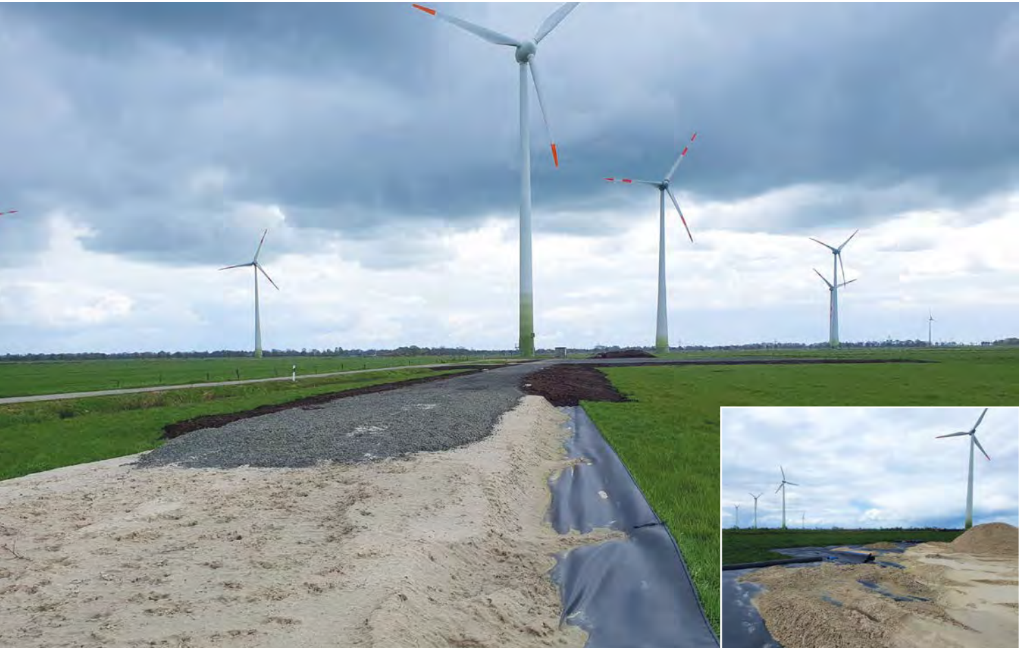
Zufahrtsweg zum Windpark
