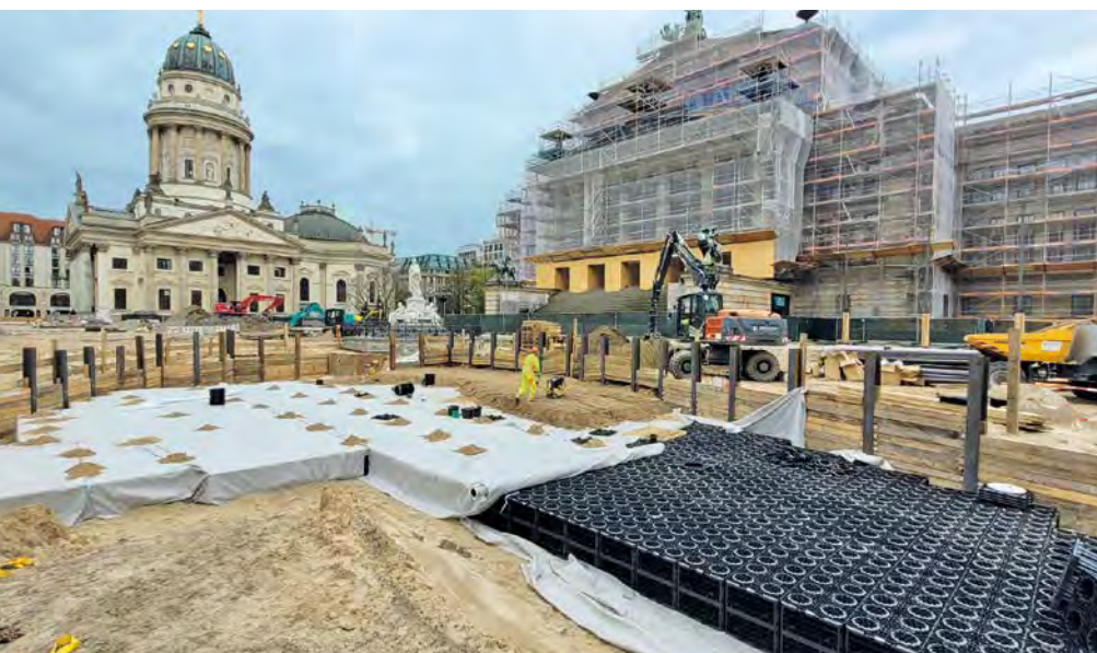
ACO Stormbrixx als Versickerungsanlage am Gendarmenmarkt in Berlin
