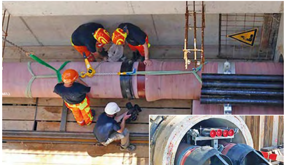
Montage der BLS-Verbindung DN 600 (Foto: vonROLL HYDRO (Deutschland) GmbH & Co. KG)
