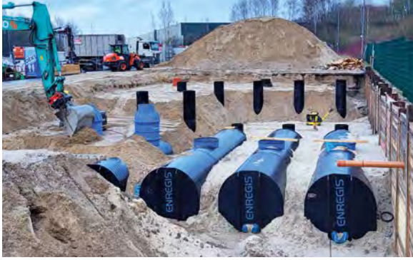
Bauliche Umsetzung: im Vordergrund fünf Behandlungsanlagen, im Hintergrund bereits teilverfüllt fünf vorgeschaltete Sedimentationsanlagen
