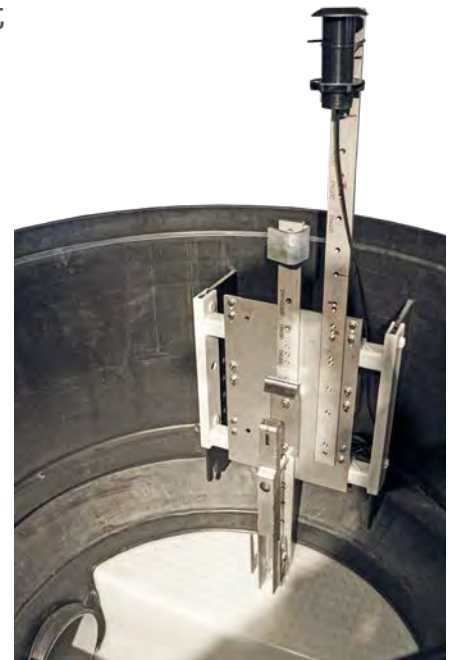
Der Schacht bleibt jederzeit begehbar
