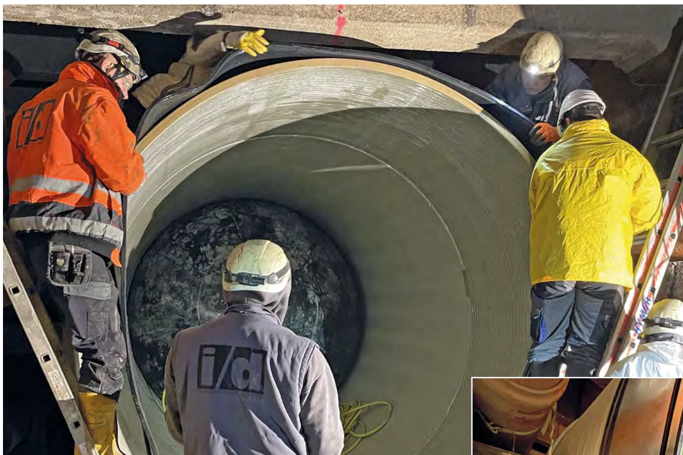
Montage von Canada TITAN XL 2765 für GFK-Rohrleitung DN 2700
