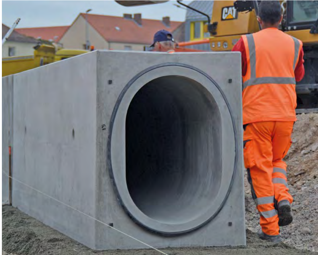
Die Retentionsrinne des Betonwerk-Neu-Ulm beim Einbau
