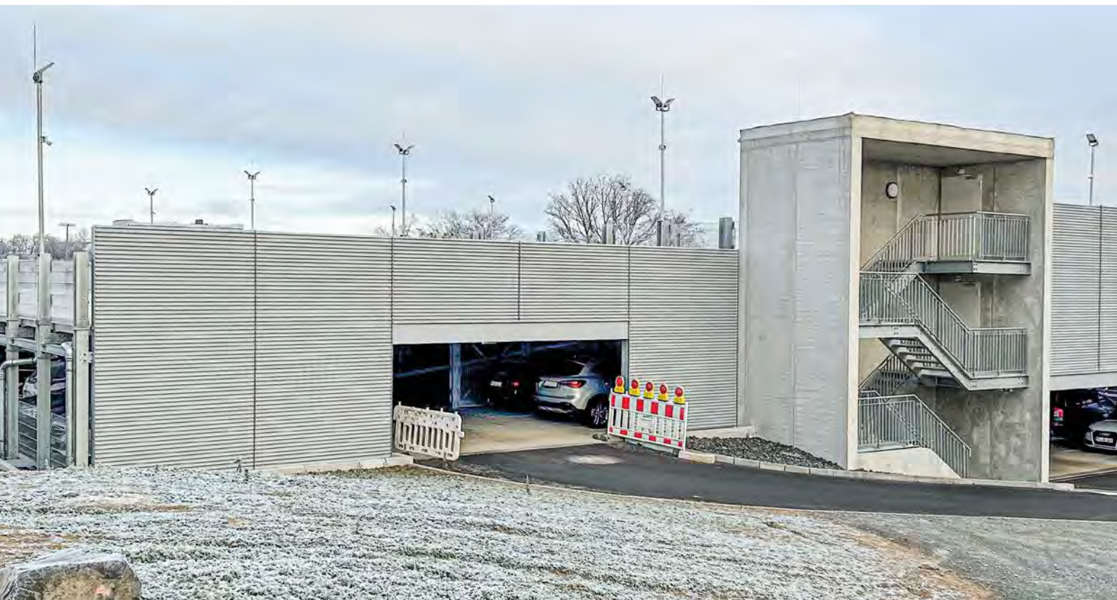
Die beiden Untergeschosse der Parkpalette am AGAPLESION-Krankenhaus in Gießen liegen für eine Entwässerung im Freispiegel zu tief, sodass die Bodenabläufe über Grundleitungen bis an einen Sammelschacht mit Hebewerk geführt werden müssen (Foto: Schmees | Wagner Partnerschaftsgesellschaft mbB)
