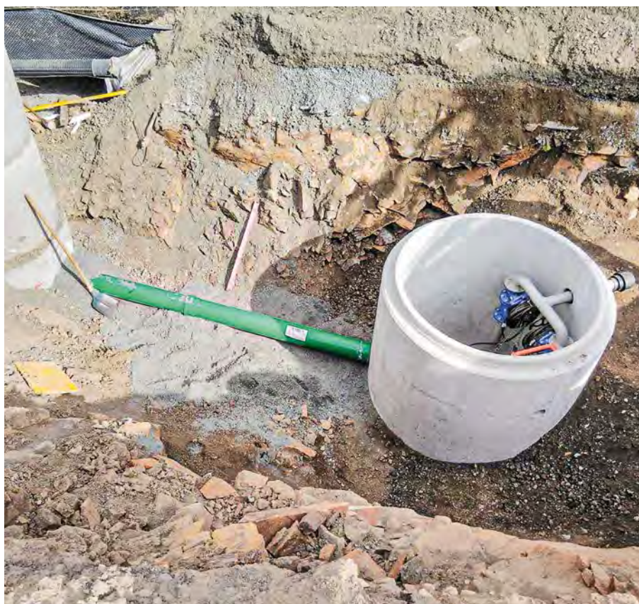
Das Hebewerk pumpt das anfallende Wasser über eine Druckleitung mit Druckschleife in einem Freiluftschrank bis in den Freispiegel-Regenwasserkanal (Foto: Hinterlang GmbH & Co. KG)
