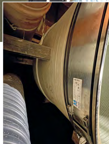
Montage der Spannbänder und des Scherbandes
